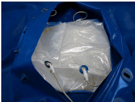
Abb. 20 Einbringen des Inliners
