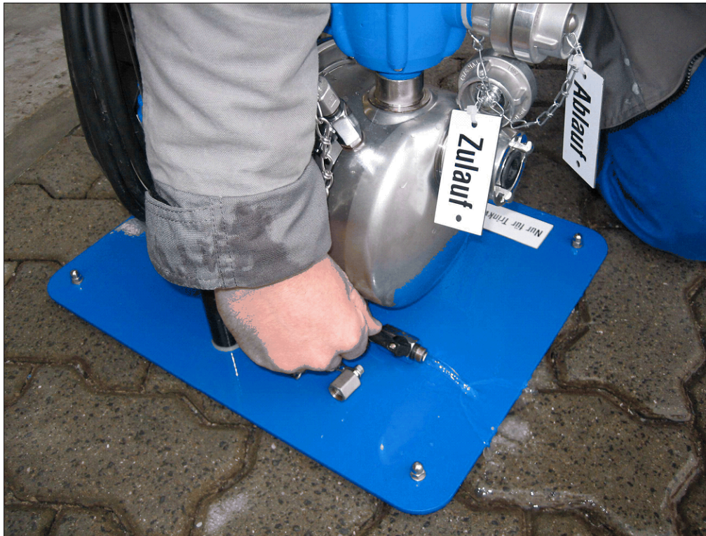
Abb. 5 Öffnen des Entwässerungsventils
